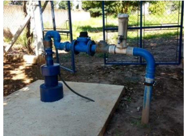
Foto 6.8 - Identificação do Poço: P11
