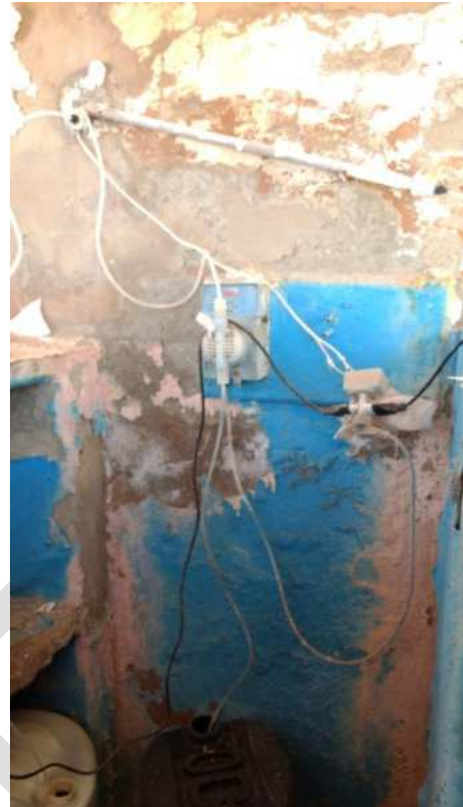
Foto 6.22 – Desinfecção no poço através de bomba dosadora
