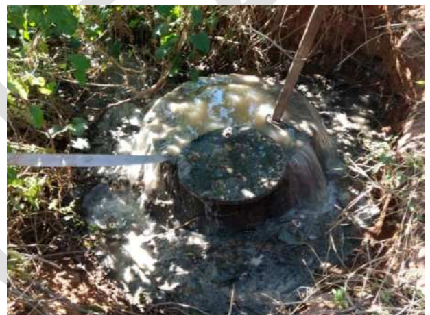
Foto 6.50 – PV transbordando e despejando esgoto na voçoroca
