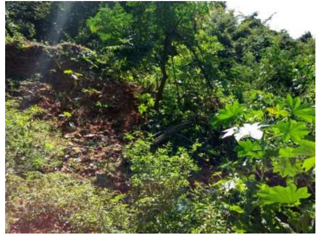
Foto 6.48 – Vista parcial da voçoroca
