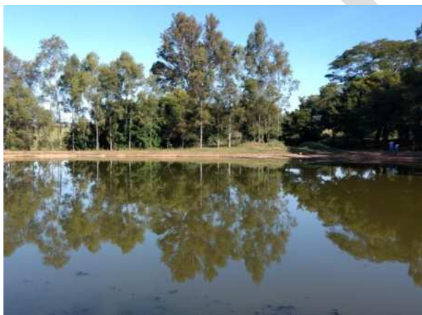
Foto 6.36 - Vista geral – Lagoa (ETE Baixão)
