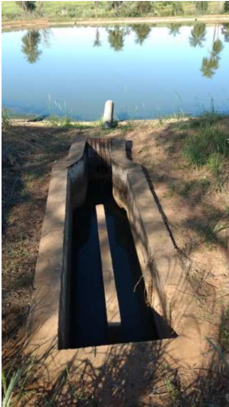
Foto 6.34 - Entrada ETE Baixão
