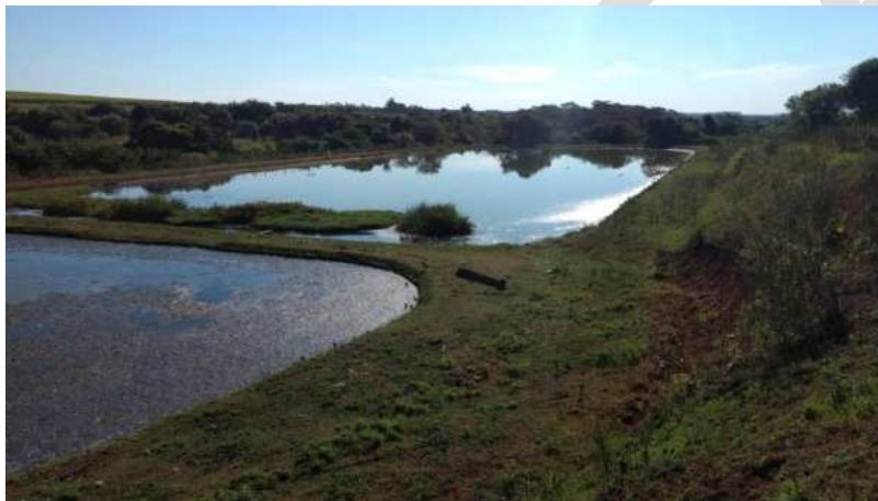
Foto 6.42 - Vista geral – Lagoa (ETE Pau d'Alho)
