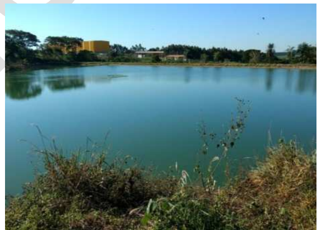
Foto 6.37 – Vista geral – Lagoa (ETE Baixão)
