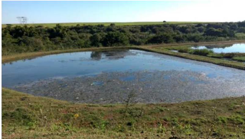
Foto 6.41 - Vista geral – Lagoa (ETE Pau d'Alho)
