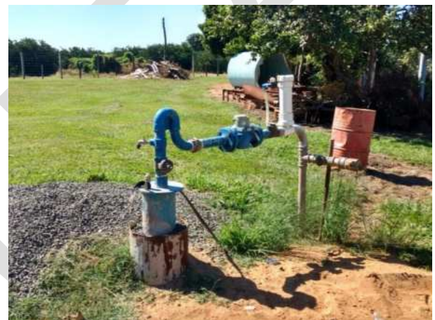
Foto 6.16 - Identificação do Poço: P09 – Álvora
