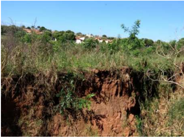
Foto 6.47 – Vista parcial da voçoroca
