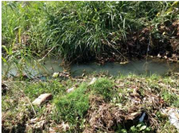
Foto 3.32 – Esgoto transbordando devido ao emissário rompido na região da voçoroca
