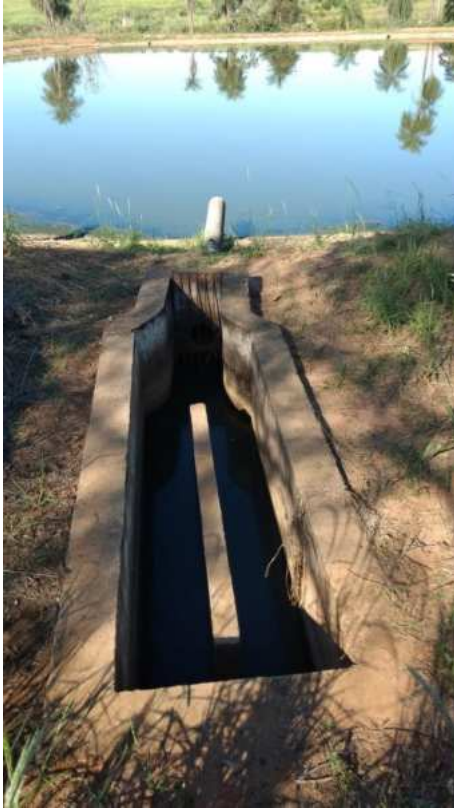
Foto 3.34 - Entrada ETE Baixão
