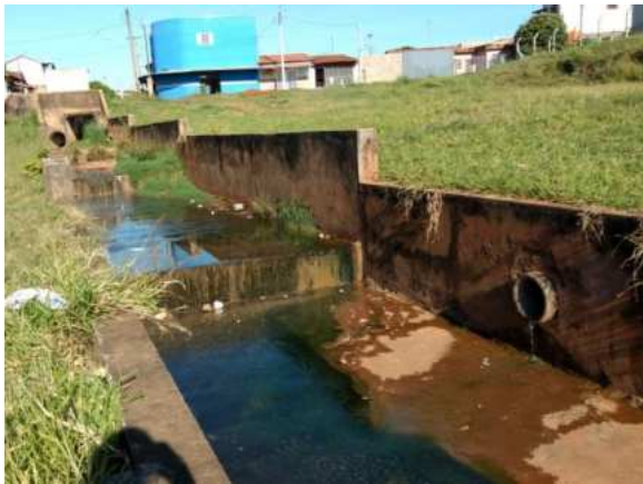
Foto 3.51 – Escada hidráulica
