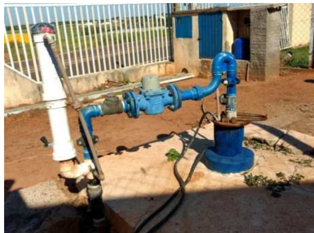
Foto 3.14 - Identificação do Poço: P17
