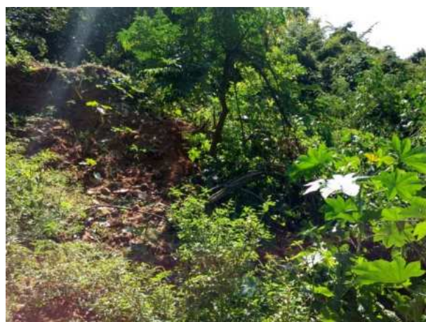
Foto 3.48 – Vista parcial da voçoroca
