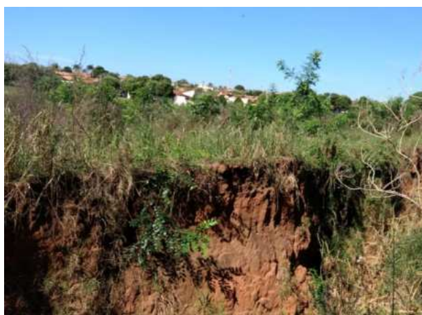
Foto 3.47 – Vista parcial da voçoroca
