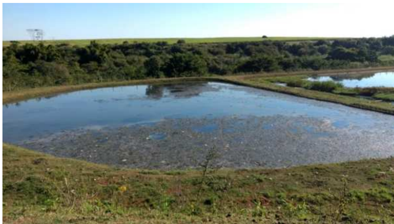
Foto 3.41 - Vista geral – Lagoa (ETE Pau d'Alho)
